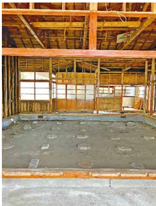
解体中の布教室
